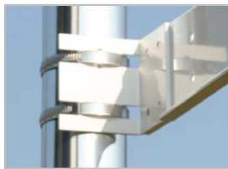
Abb. 2: Montage an einem Mast mit Schneckengewinde-Schellen
