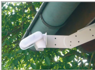
Abb. 6 Beispiel für den Einsatz des Gelenk-Auslegers: Durch den Gelenk-Ausleger ragt der Sensor unter dem Dachvorsprung hervor. Sonne kann ungehindert auf die Sensoren einwirken.
