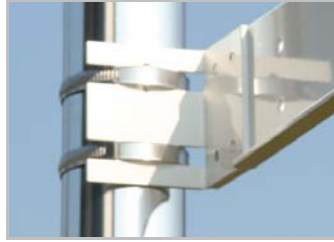
Bsp. 2: Montage an einem Mast mit Schneckengewinde-Schellen
